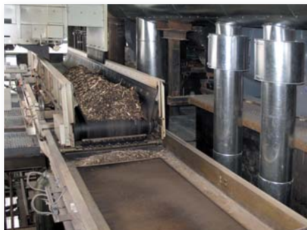
Doprava biomasy do kotla
